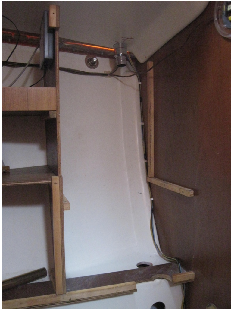
Septitank och gamla anslutningar demonterade.
