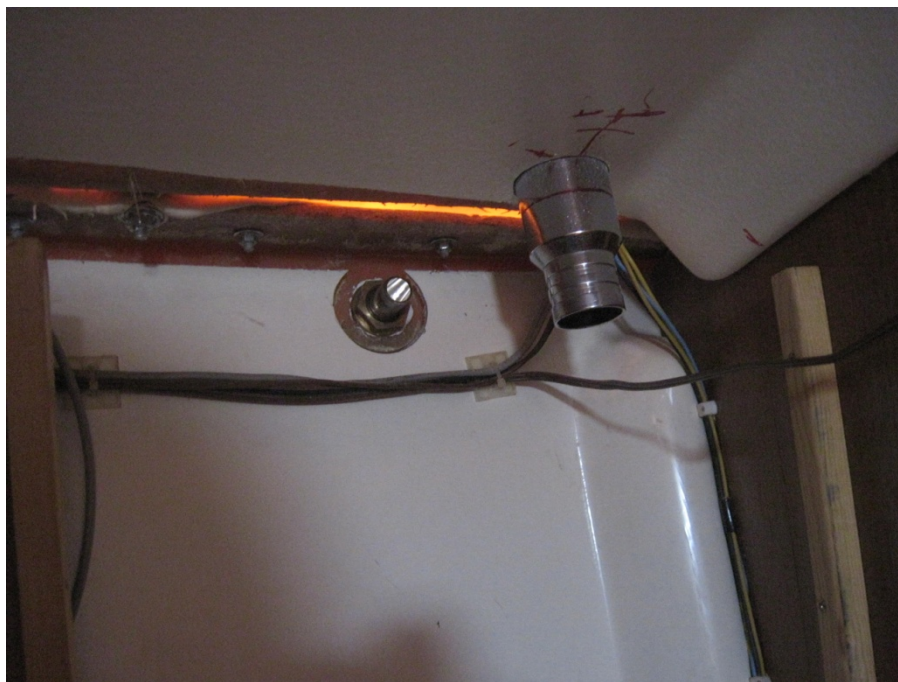
Ny 19mm 'Tankventil flush rak' för avluftning och Däcksförskruvning monterade
