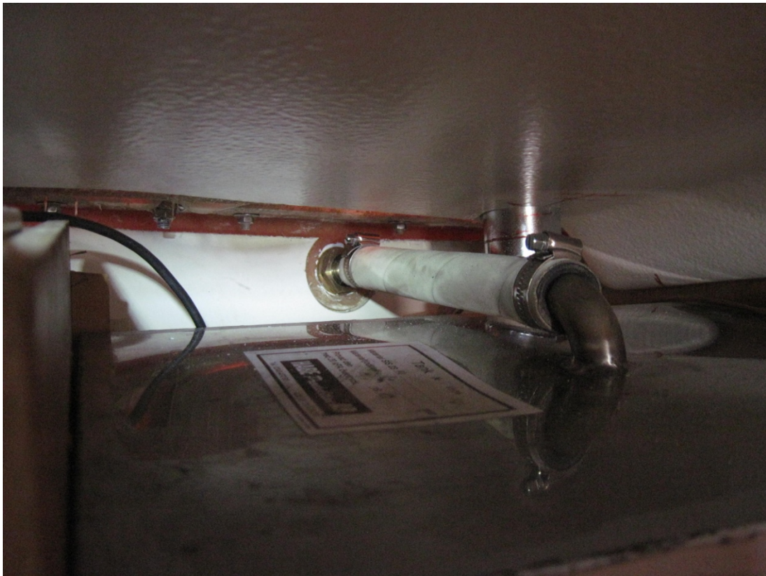
Septitanken återmonterad med ny slang för avluftning.
