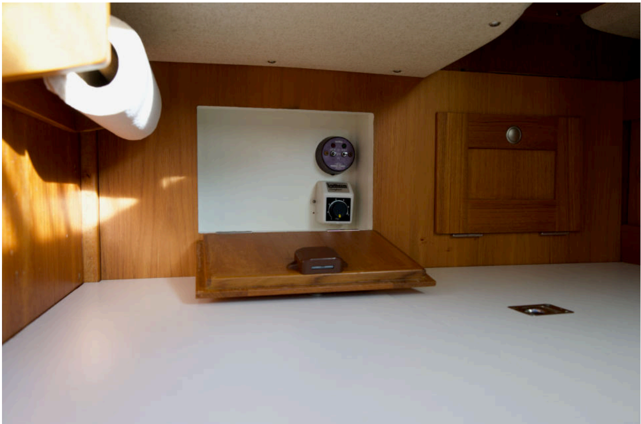
Bild 4 - Skåp med kontrollenheter
